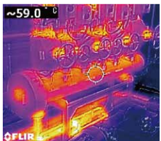
蒸気ヘッダーの放熱箇所の確認
