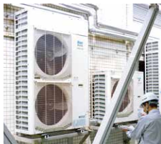
空調設備設置状況の確認
