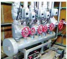
蒸気ヘッダーの放熱箇所の確認
