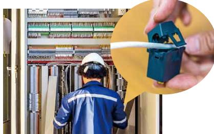
制御盤内の高調波センサ
